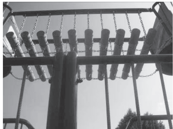
図2 転落が起こった吊り橋の拡大写真
