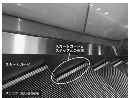
図2 受傷した場所の周囲。スカートガードとステップの隙間は約4 mmであった。
